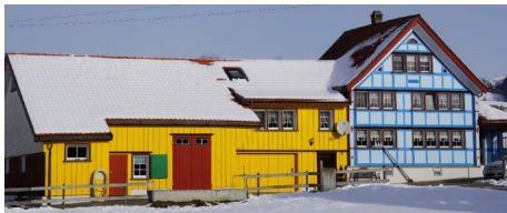
Appenzell, Enggenhüttenstrasse. Foto: A. D'Errico
