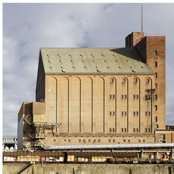
Siloturm von Hans Bernoulli, erbaut 1923 - 1926
